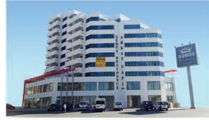
08 Gümüş Residence / A blok
